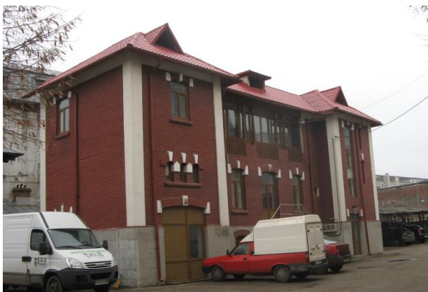
Figura 50: Clădirea în care se va amenaja Centrul de control – Str. Văleni nr. 32 (fotografii din arhiva proprie)
